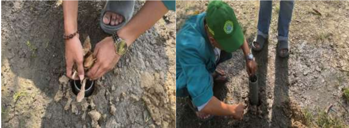
Gambar 2. Proses pengeboran dan pembuatan lubang resapan biopori di lokasi rawan genangan
